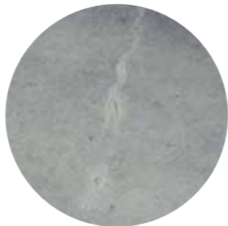
打設初期に生じた微細な亀裂が、2年後RCブロックによって閉塞されています。
